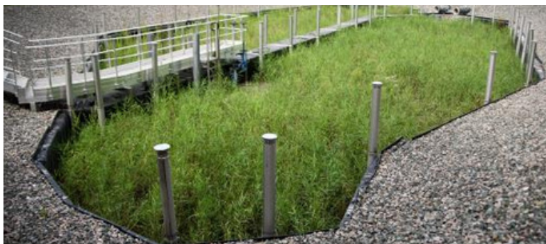
Hydr'Epur® installé à Marcy-l'Etoile
